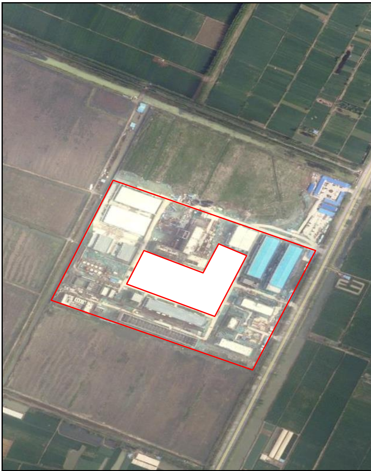
2018 年 8 月，主体工程完工。
